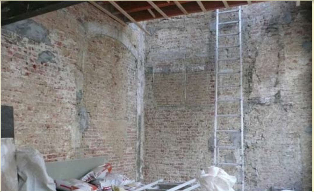
Toegemetselde deuroplijsting in de achtermuur en oudere rechter scheimuur van het 19de-eeuwse pand Sint-Katelijnevest 6
