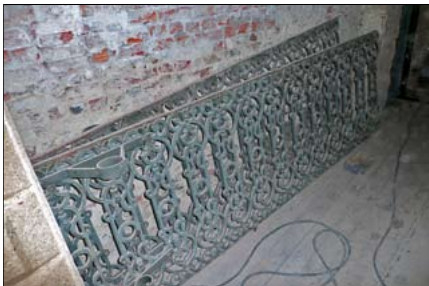
De fraaie gietijzeren balustrade uit 1886 wacht op herplaatsing - Foto's Petra Maclot, juli 2008
